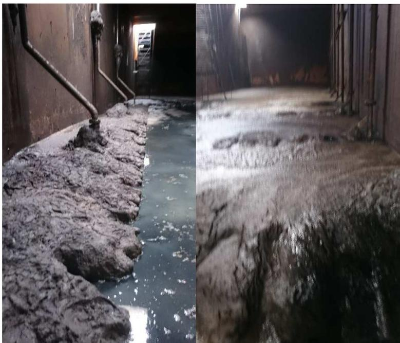
**Photos 2 et 3 : Vue des rampes d'aération installées au fond du bassin biologique après vidange de l'ouvrage**
