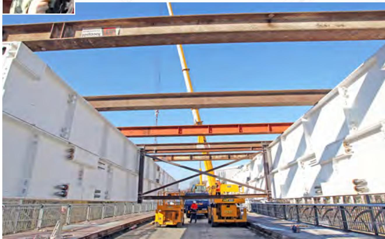
Le lancement officiel des travaux de démolition du pont de Paris a eu lieu le 18 février avec le début du grignotage du tablier. Il sera entièrement déconstruit à la mi-avril puis remplacé par un tablier à structure métallique pour être normalement rouvert à la circulation le 21 décembre 2013.
