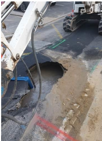
Photos 6 à 7 : réparation de la fuite d'eau rue de Sénéfontaine
