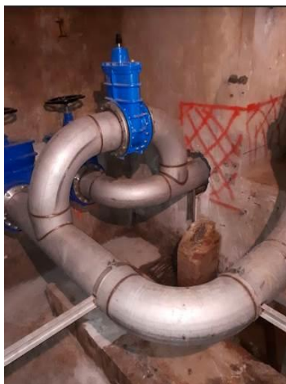
Photos 9 à 11 : Remplacement de l'hydraulique du réservoir parc des Eaux et installation d'un analyseur de chlore en continu
