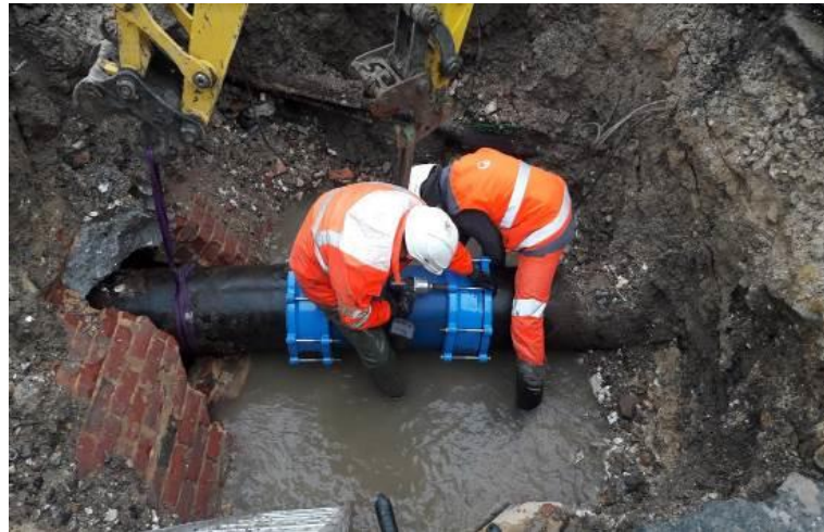
Photos 3 à 5 : réparation de la fuite d'eau boulevard de l'Assaut
