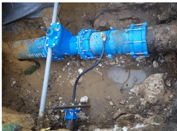
Photo 8 : vanne installée à proximité de la voie ferrée
