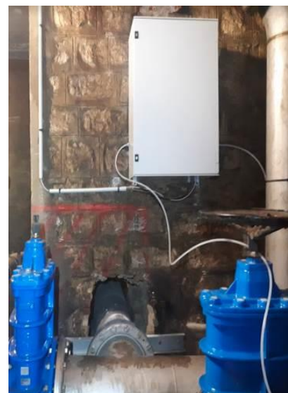
Photos 9 à 11 : Remplacement de l'hydraulique du réservoir parc des Eaux et installation d'un analyseur de chlore en continu
