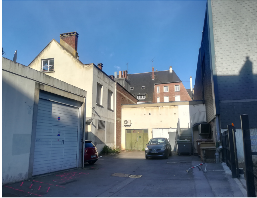
Arrière des commerces Rue Carnot
