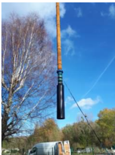
Photos 1 et 2 : Vue de la pompe du forage F1 et inspection des sources de Friancourt
