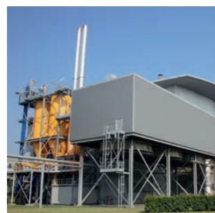
↑ CENTRE DE VALORISATION ÉNERGÉTIQUE
