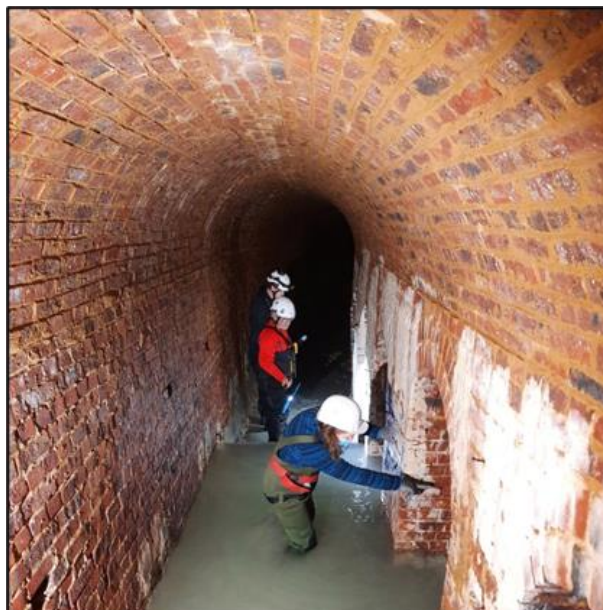
Photo 4 : Inspection des sources de Friancourt
