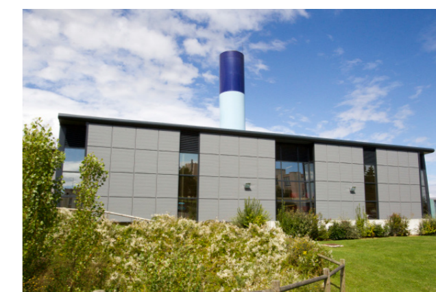
Réseau de chaleur
